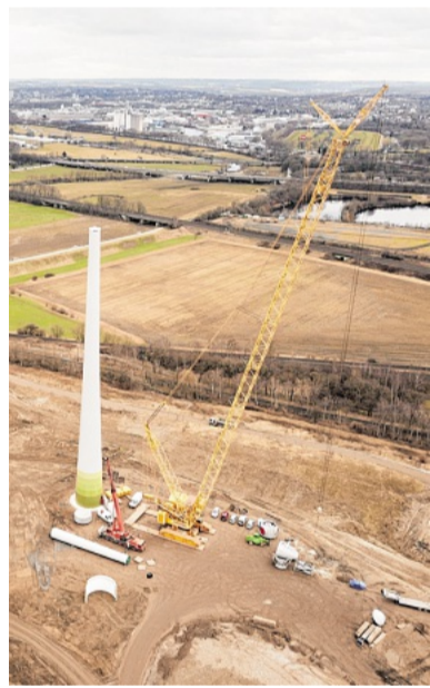
Der Turm der Windkraftanlage ragt schon in die Höhe. FOTO: ESR
